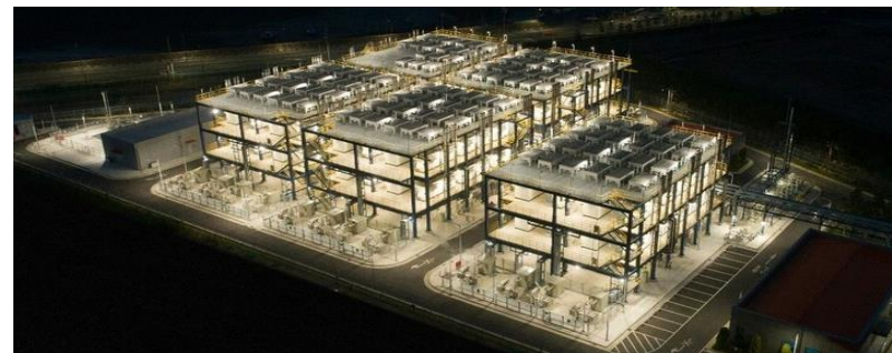
부생수소 활용 발전용 연료전지 (PAFC, 50 MW) (대산, '20.7)
